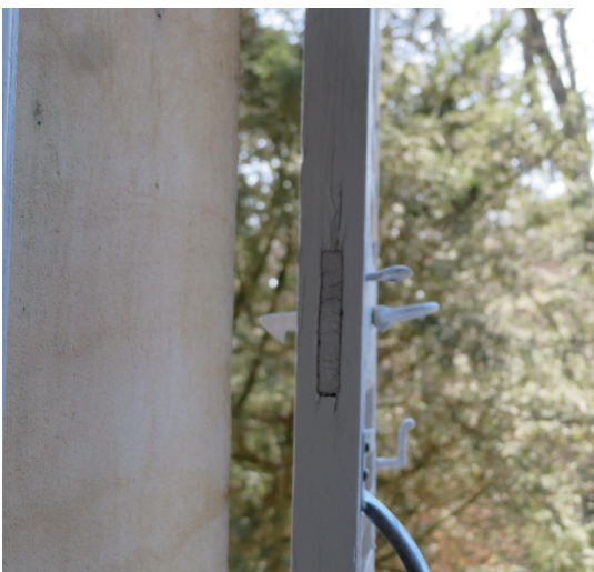
Figure 4. Arrêt à paillette, vue latérale.
